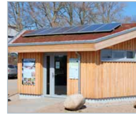
Der Holz-Pavillon mit seinem Grasdach und einer Photovoltaik-Anlage gibt Besuchern viele Informationen zum Klimawandel. Er befindet sich neben dem Tourist-Service in Schönberg-Kalifornien, An der Kuhbrücksau 2.
